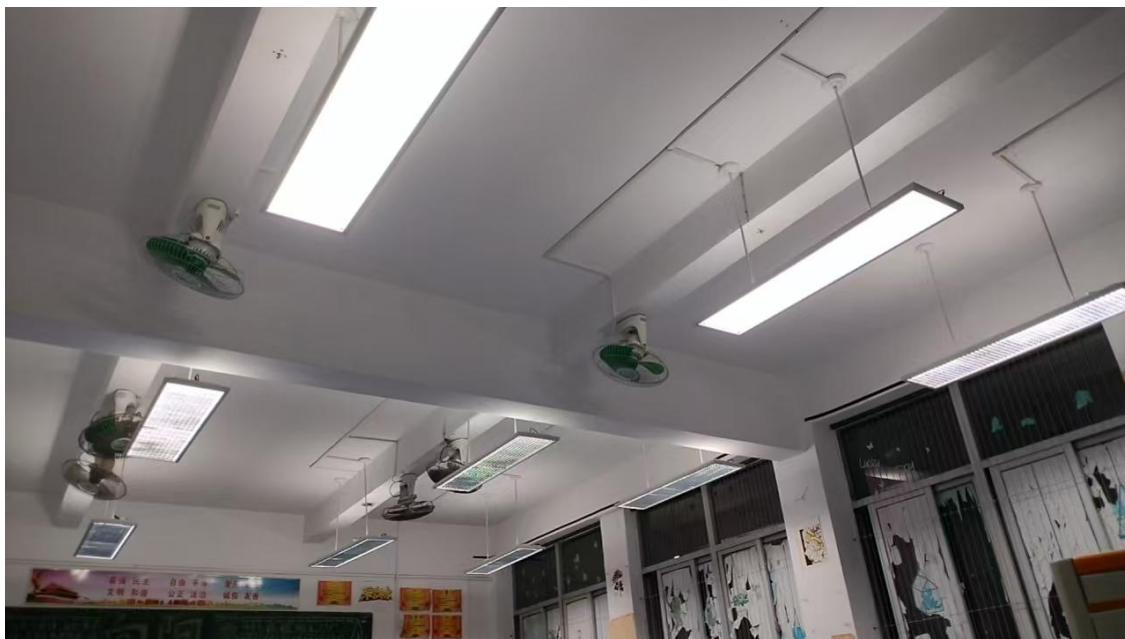
图 6.4.2 教室护眼灯的安装
