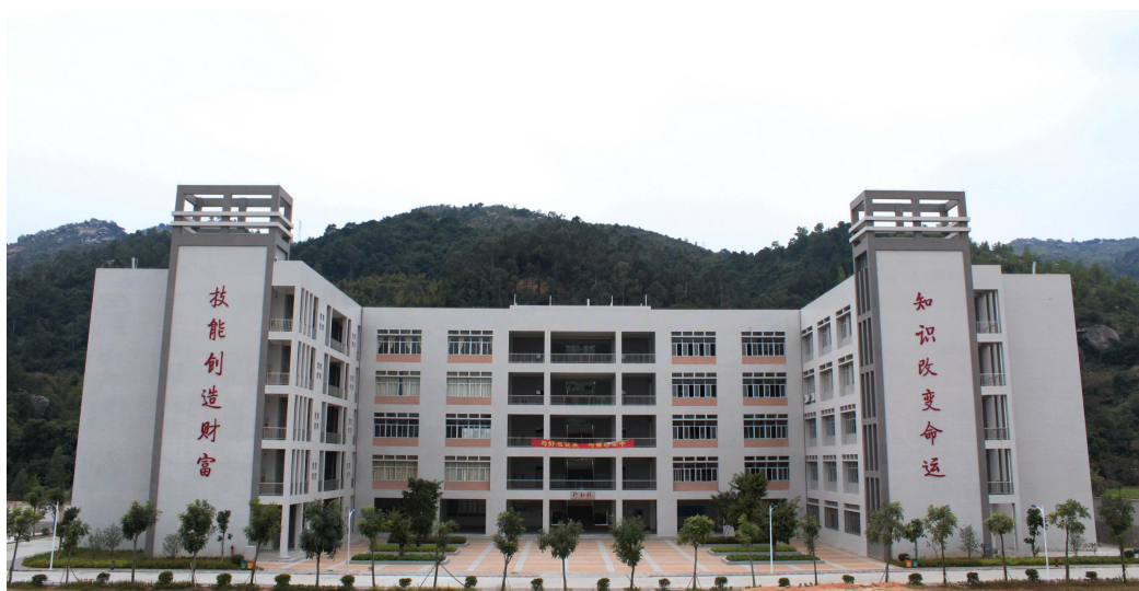
图 1.4-1 实训中心-行知楼
